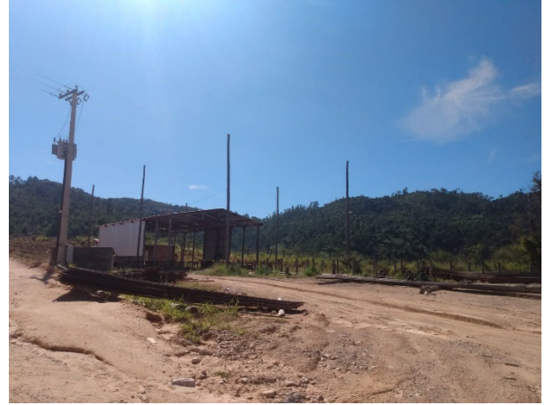
Foto 4: Situação atual das Estruturas no Canteiro operacional (24/04/2023)
