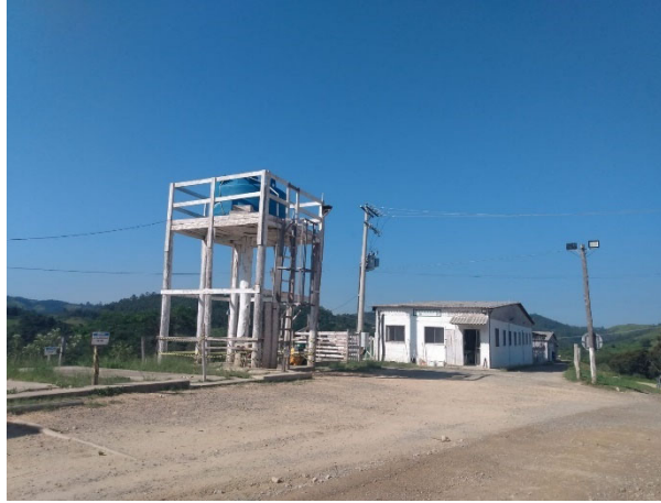
Foto 3: Situação atual das Estruturas no Canteiro operacional (31/03/2023)
