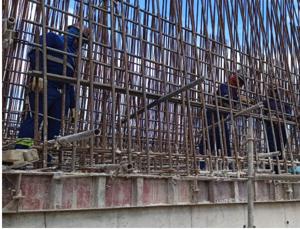
Foto 6: Continuidade da armação de aço da parede lateral direita do módulo 2. 24/01/2023.
