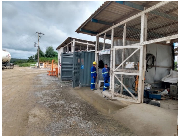
Foto 1: Situação atual das Estruturas no Canteiro operacional (30/01/2023)
