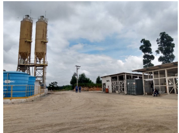
Foto 2: Situação atual das Estruturas no Canteiro operacional (24/02/2023)
